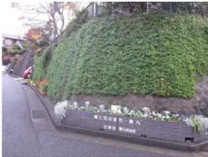
住宅地のゲートの擁壁緑化
